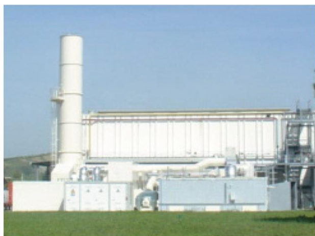
Sistema di abbattimento emissioni Reparto Verniciatura
