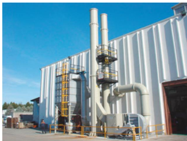
Sistema di abbattimento emissioni Reparto Pressofusione
