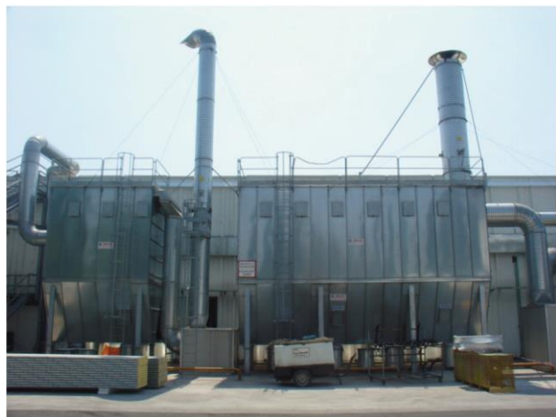
Sistema di abbattimento emissioni Reparto Saldatura
