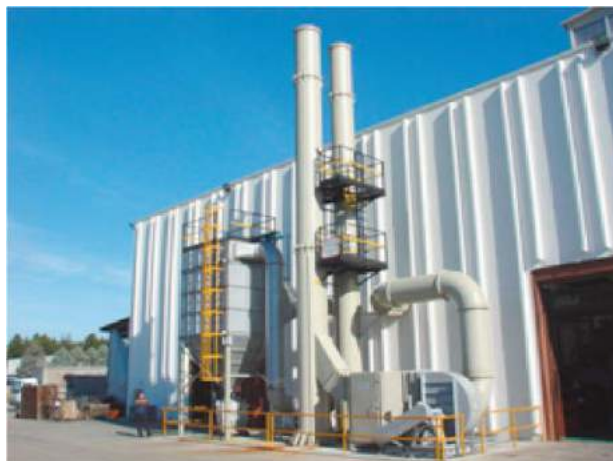
Sistema di abbattimento emissioni Reparto Pressofusione
