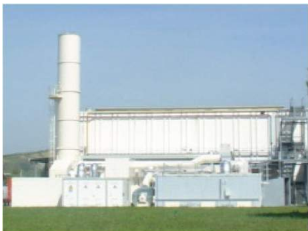
Sistema di abbattimento emissioni Reparto Verniciatura
