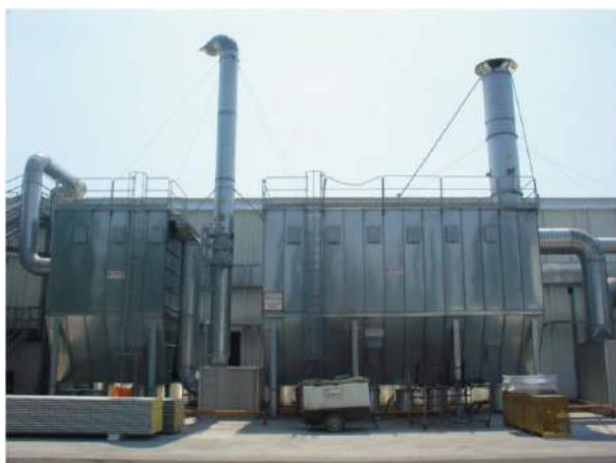
Sistema di abbattimento emissioni Reparto Saldatura
